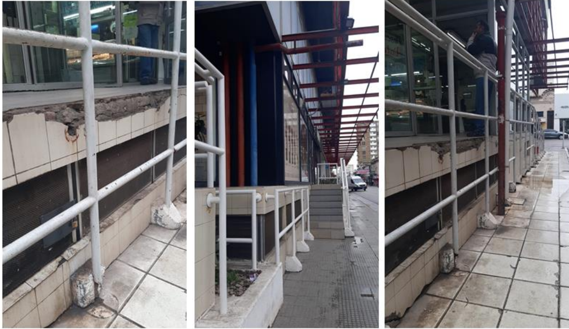
Imagen 23: Desprendimiento, hundimiento en pisos de vereda pública. Deterioro y falta de amuramientos de barandas.
