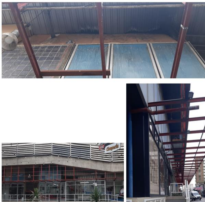
Imagen 22: Deterioro de estructuras debido a la presencia de excremento de aves.
