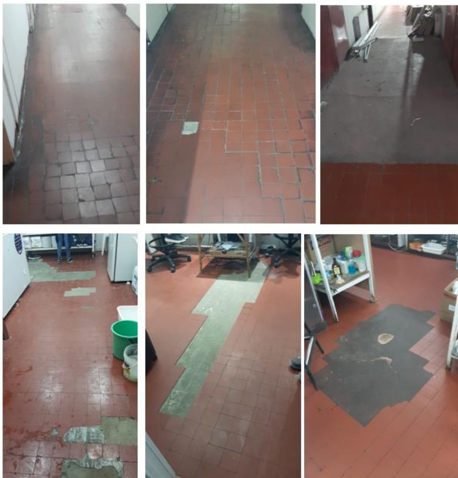
Imagen 7: Locales comerciales con pisos deteriorados y disgregados.
