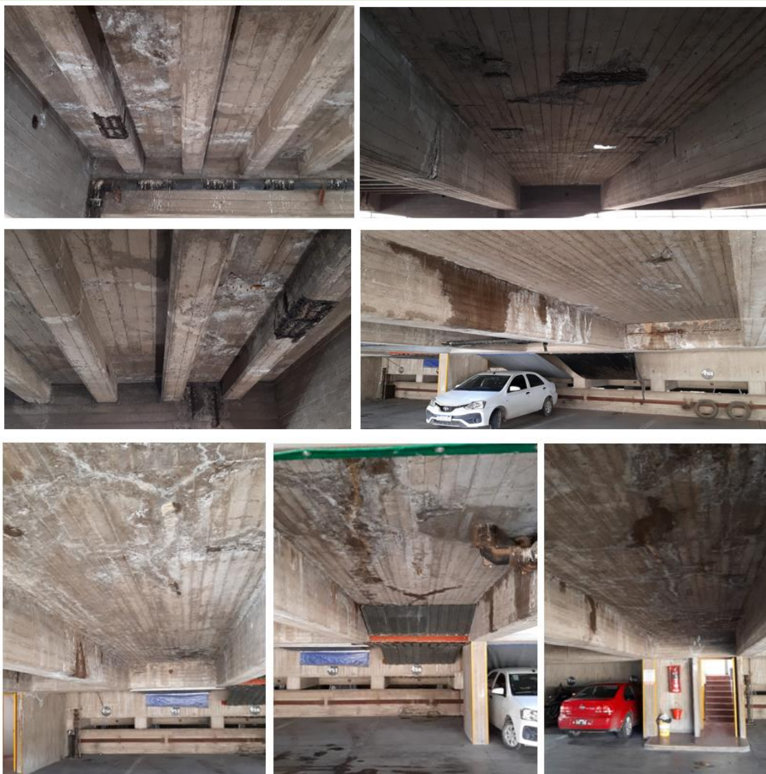
Imagen 19: Eflorescencias, desprendimiento de material, armadura expuesta en cocheras.
