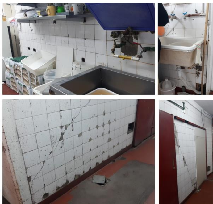
Imagen 10: Revestimientos deteriorados, locales comerciales.
