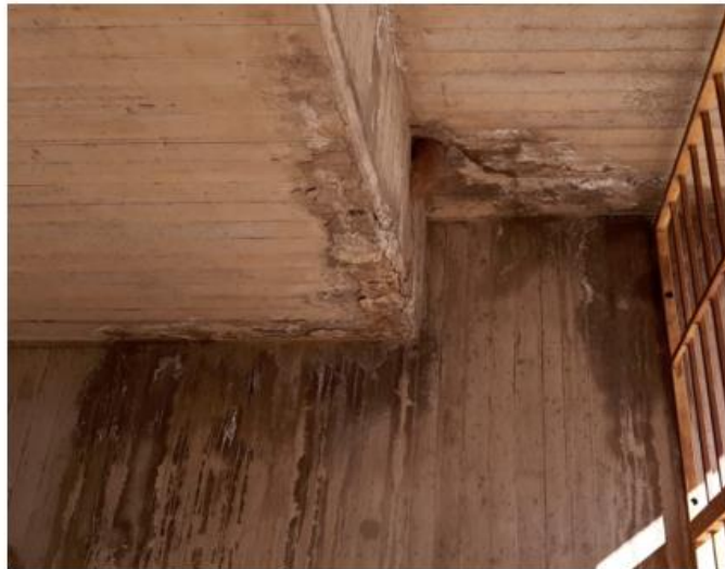
Imagen 20: Eflorescencias, desprendimiento de material, armadura expuesta en espacios comunes.
