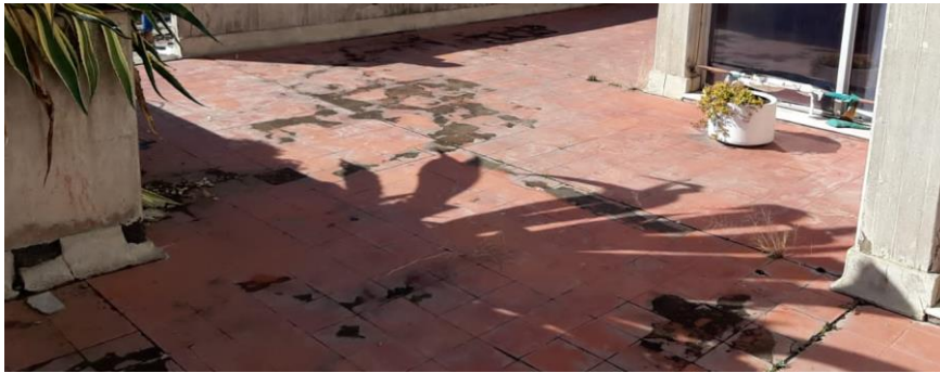
Imagen 2: Desprendimiento de pisos en terraza.
