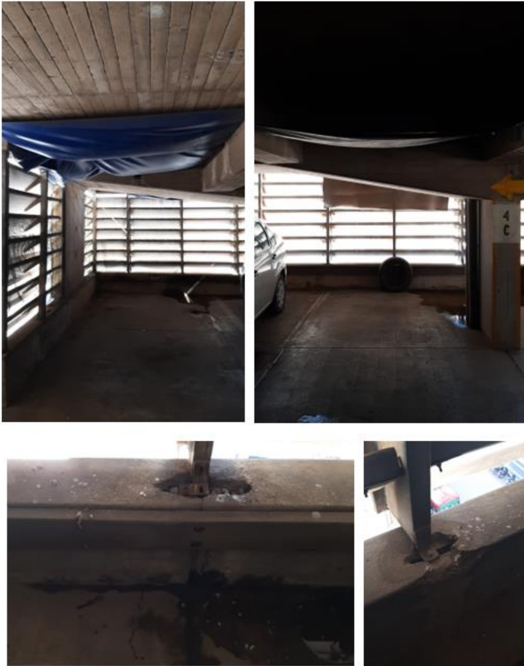
Imagen 18: Presencia de filtraciones en losa, lonas colocadas en cocheras. Falta de anclajes en parasol.
