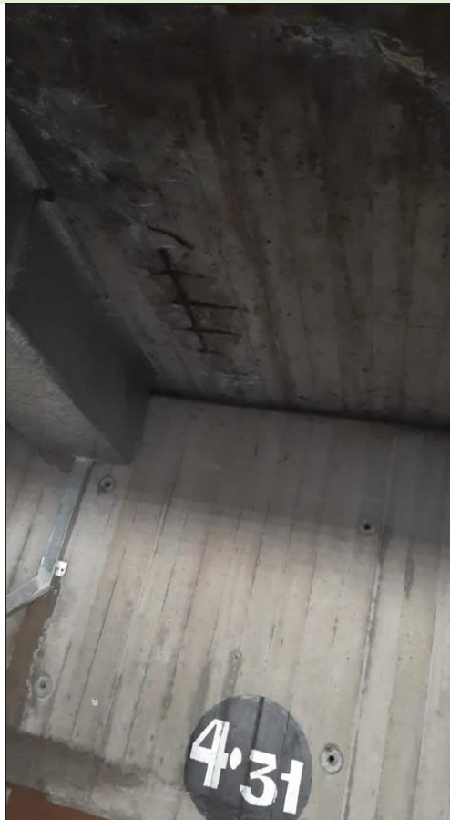
Imagen 16: Cochera 4-31 en piso 4, armadura expuesta, Eflorescencias que indican presencia de humedad.
