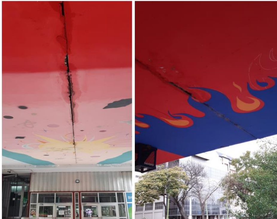
Imagen 21: Filtración desde rampa de acceso en cocheras de primer piso.
