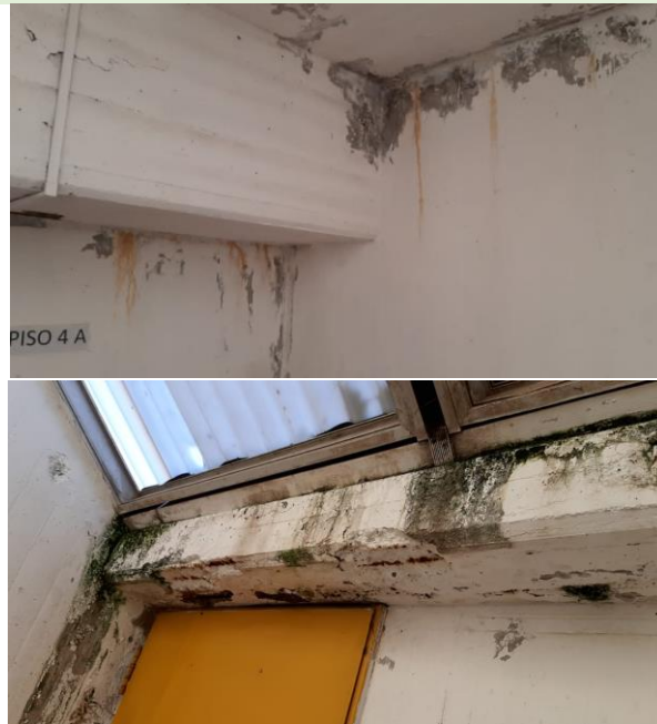
Imagen 25: Eflorescencias que indican presencia de humedad sobre espacio común.
