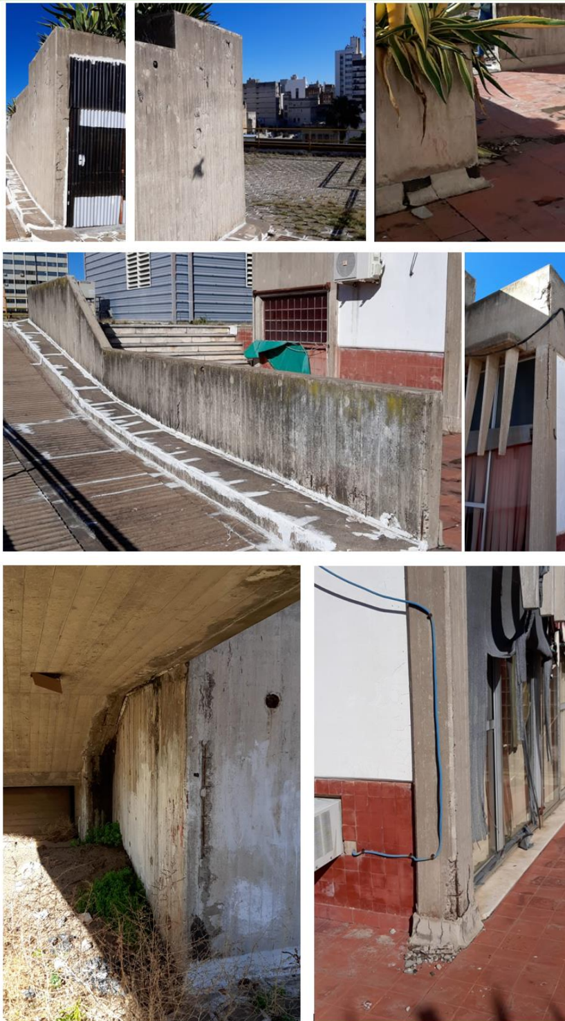
Imagen 3: Desprendimiento de hormigón en terraza.
