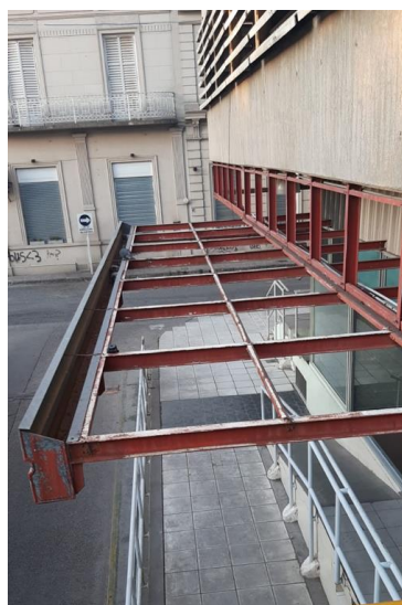
Imagen 15: Estructura metálica sobre fachadas deteriorada.
