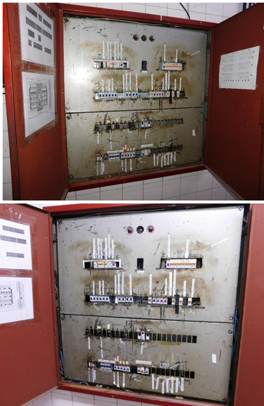
Ilustración 45: Tablero de iluminación general
