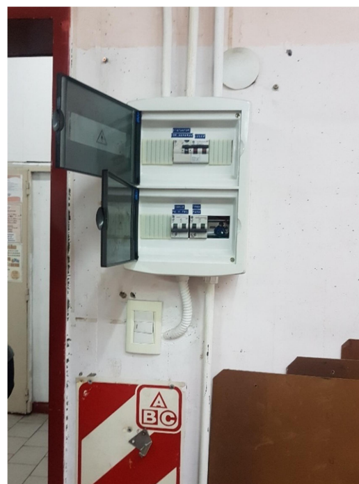
Foto 171 Tablero eléctrico instalado
