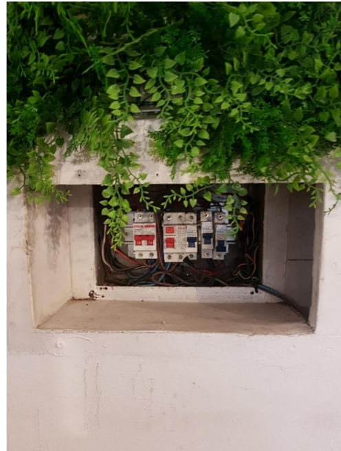
Foto 6: Tablero sin tapas interna ni externa – Riesgo eléctrico
