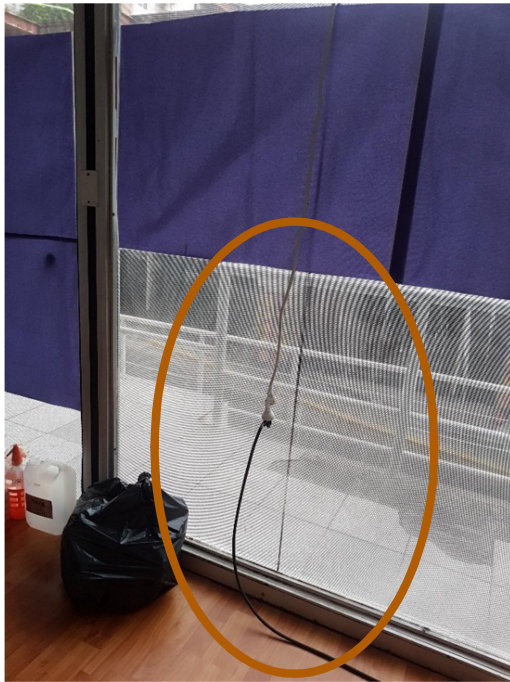
Foto 71 Conexión entre cableados – Riesgo eléctrico
